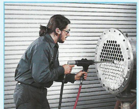
Wärmetauscher in Kälte- und Klimaanlage sind meist schwer zugänglich, da sie in Energiezentralen mit anderen Aggregaten gemeinsam installiert wurden. Wartungen, speziell Reinigungen der Rohre, sind aber durch Ablagerungen von Algen und anderen im Wasser befindlichen Stoffen (Kalk, Salze, Schwebstoffe)
